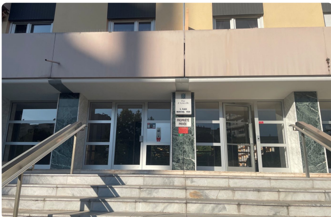
1. L'entrée de la copropriété, au 5 place Maréchal Foch.
